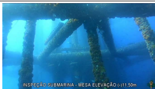
Foto 6: Estrutura da plataforma PCP-2 (jaqueta Mesa - 11.50m) coberta por colônias de Coral-sol.
