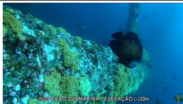
Foto 4: Estrutura da plataforma PCP-2 (jaqueta face B) coberta por colônias de Coral-sol.
