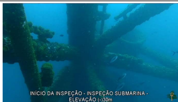
Foto 1: Estrutura da plataforma PCP-2 (jaqueta face B) coberta por colônias de Coral-sol.
