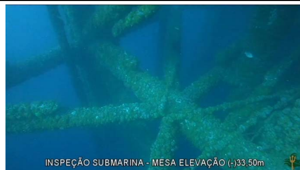
Foto 10: Estrutura da plataforma PCP-2 (jaqueta Mesa - 33.50m) coberta por colônias de Coral-sol.
