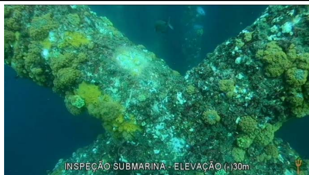
Foto 3: Estrutura da plataforma PCP-2 (jaqueta face B) coberta por colônias de Coral-sol.
