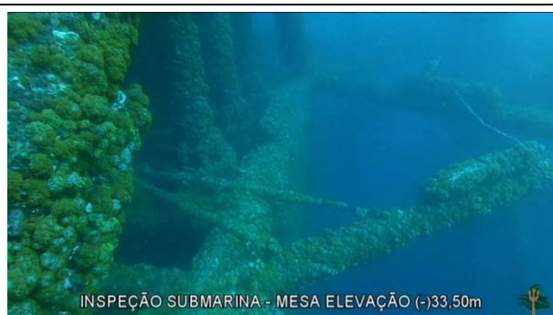
Foto 11: Estrutura da plataforma PCP-2 (jaqueta Mesa - 33.50m) coberta por colônias de Coral-sol.
