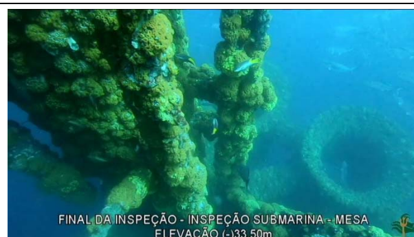
Foto 12: Estrutura da plataforma PCP-2 (jaqueta Mesa - 33.50m) coberta por colônias de Coral-sol.
