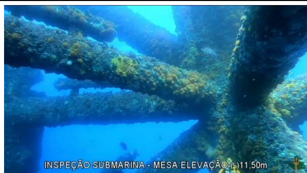
Foto 7: Estrutura da plataforma PCP-2 (jaqueta Mesa - 11.50m) coberta por colônias de Coral-sol.
