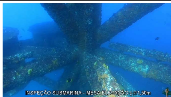
Foto 8: Estrutura da plataforma PCP-2 (jaqueta Mesa - 11.50m) coberta por colônias de Coral-sol.
