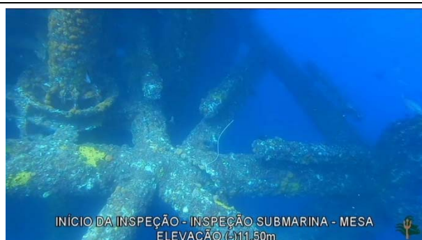
Foto 5: Estrutura da plataforma PCP-2 (jaqueta Mesa - 11.50m) coberta por colônias de Coral-sol.
