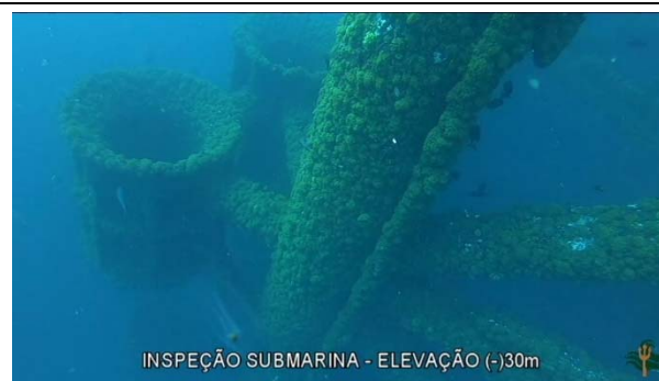
Foto 2: Estrutura da plataforma PCP-2 (jaqueta face B) coberta por colônias de Coral-sol.
