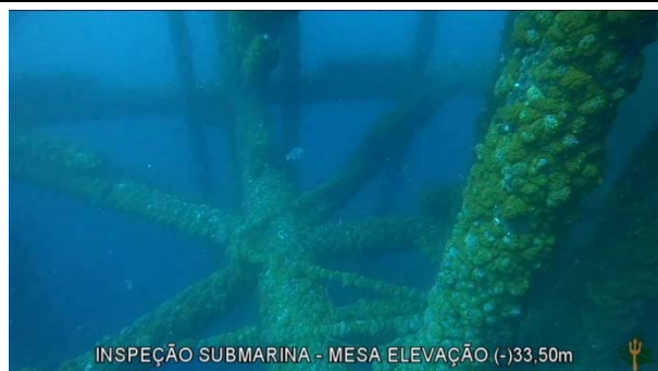
Foto 9: Estrutura da plataforma PCP-2 (jaqueta Mesa - 33.50m) coberta por colônias de Coral-sol.
